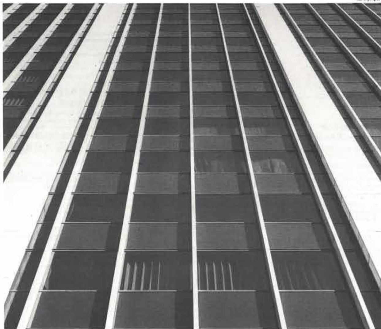
Σύγχρονη οικόδομη κατασκευή
